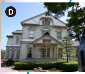
旧師団長官舎は1910年に建てられた市内に残る数少ない明治期の和洋折衷の木造建築物。
